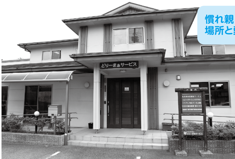
向かって建物左側が夢ハウスになります
